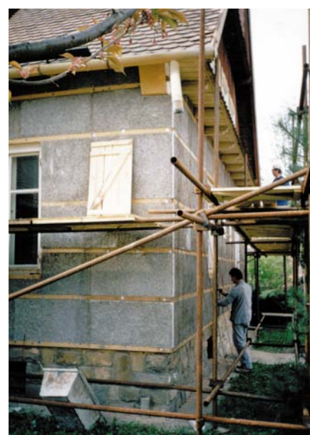
Nedašov - rekonstrukce všech budov za provozu
