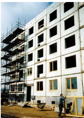
Vysoké Mýto - rekonstrukce bývalého sovětského paneláku
