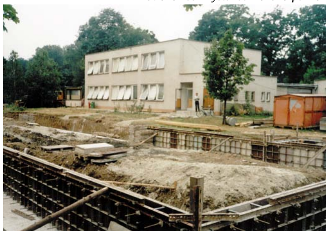
Otrokovice - výstavba nového pavilonu
