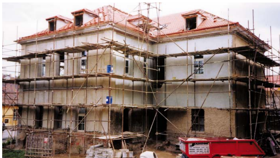
Praha, Záběhlice - rekonstrukce Domu pokojného stáří pro opuštěné lidi
