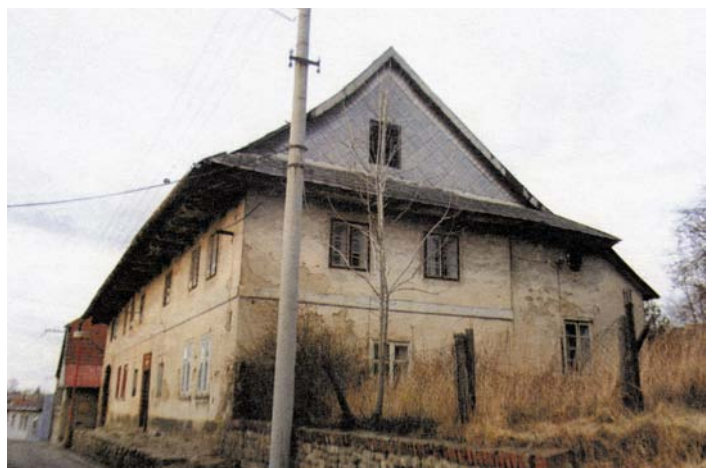
Litomyšl - dar rodiny Plchovy z USA pro opuštěné děti (původní stav před rekonstrukcí a dostavbou)
