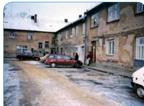
Objekty v Husově ulici před rekonstrukcí
