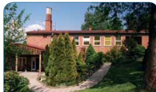
Objekt Domu pokojného stáří v Mostní ulici byl obklopen zelení
