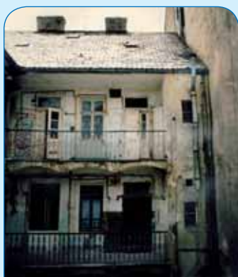
Tak vypadal činžovní dům v Rybalkově ulici před rekonstrukcí...
