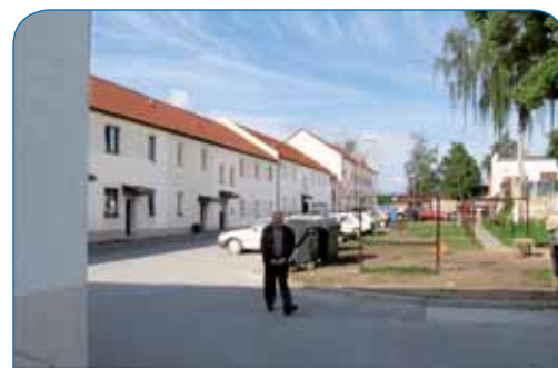
Rekonstruované a nové domy v Husově ulici
