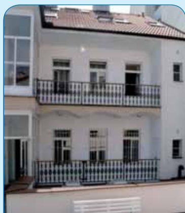
...a tak po rekonstrukci
