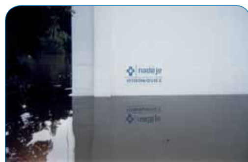
Voda při povodních v roce 1997 zaplavila Domov až do výše 3,5 metrů
