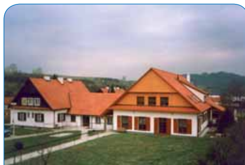
Nová kuchyň s jídelnou a se zázemím pro zaměstnance byla postavena ve stylu nedašovských domků
