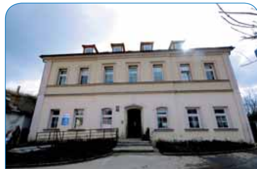
Než Dům Naděje v Záběhlicích přivítal první klienty, prošel celkovou obnovou
