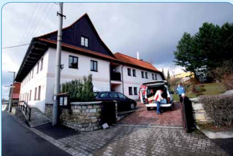
Díky obětavosti, nadšení a víře mnoha lidí se tento dům stal po rekonstrukci domovem pro opuštěné děti
