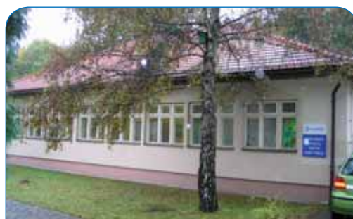
Domek v místní části Rokytnice slouží pro činnost denního stacionáře
